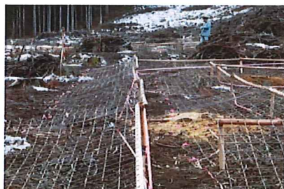
写真2 ワイヤーメッシュの設置状況
