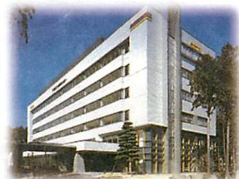
技術センター(平成14年建設)
