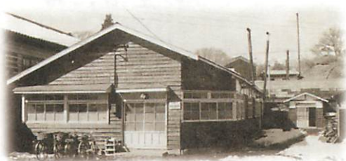
移転1年後に焼失してしまった工場（昭和30年）
