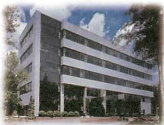
現本社棟(伊那市西箕輪 平成2年建設)
