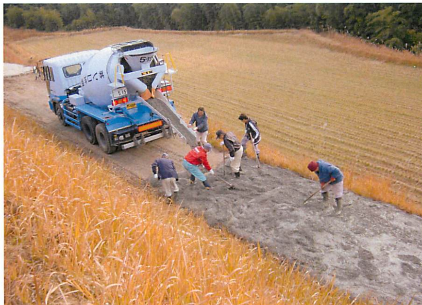
平成13年9月29日施行 村道61号線他 小松原地区 L=230.0m、W=2.0~3.0m 生コンクリート V=79.5m 3
