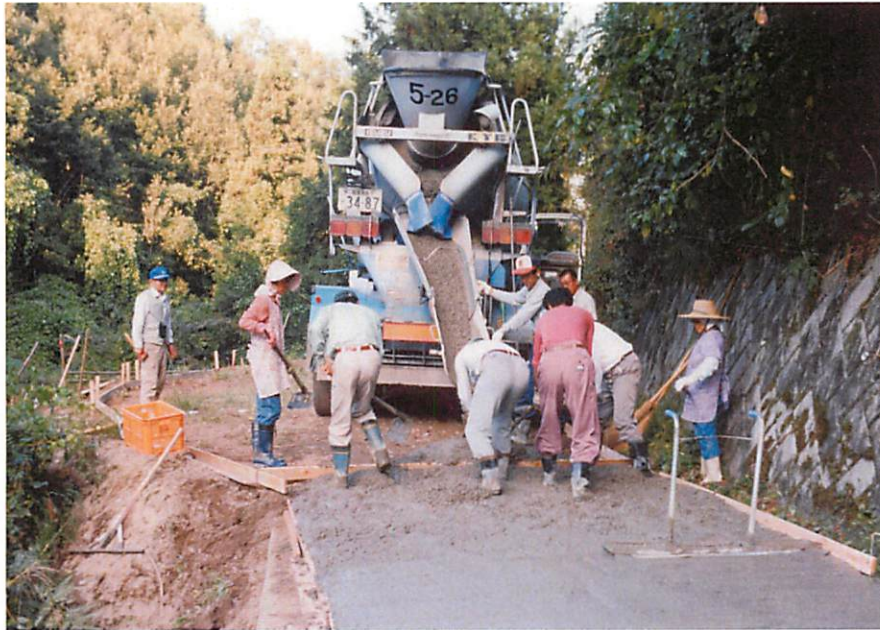
平成14年11月30日施行 村道481号線 東田地区 L=40.0m、W=3.5m 生コンクリート V=16.6m 3
