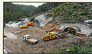
③佐久間第1トンネル(坑口)
